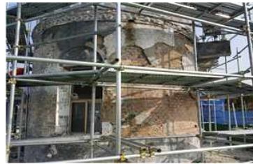
육상건물 타일 상세(페인트제거 후)
