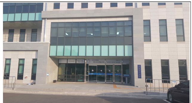
<청사 주출입구 캐노피 설치>
