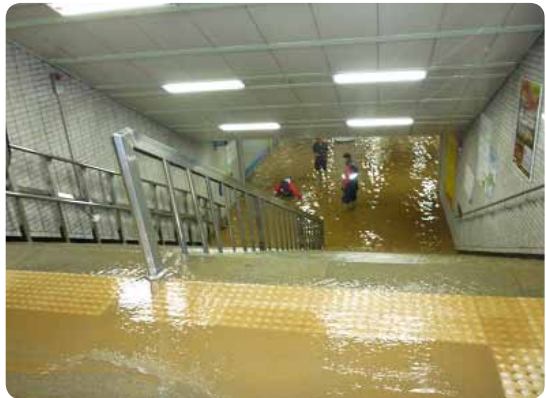
[사진 3-19] 사당역 노면수 유입 (사진: 국토해양부)
