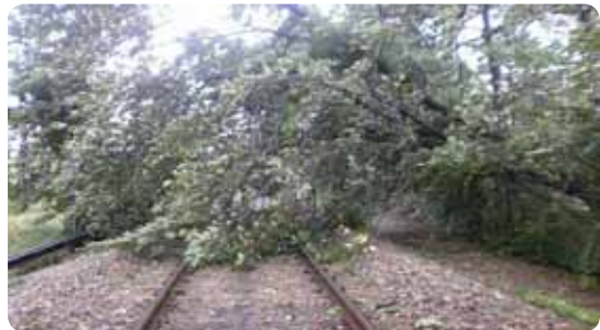
[사진 3-15] 강풍에 의한 수목 전도로 운행선 지장 (경춘선, 신공덕-퇴계원, 사진: 국토해양부)
