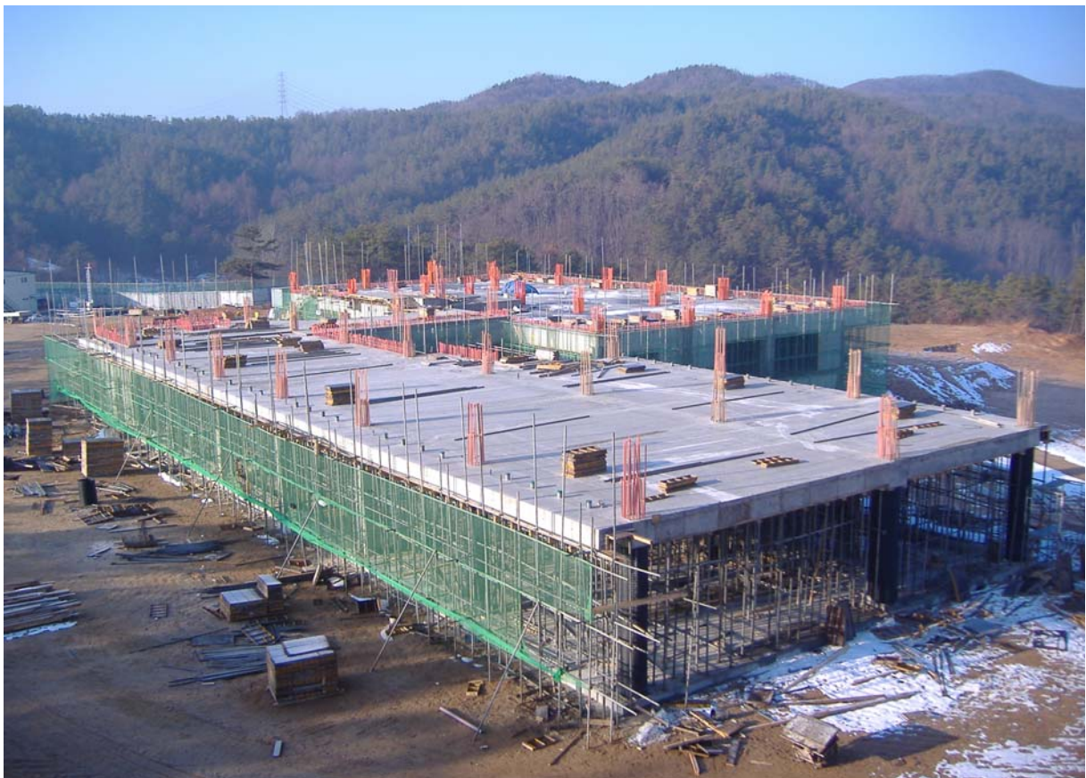
[그림 3-25] 기상위성센터 신축 1차공사 준공 후 사진
