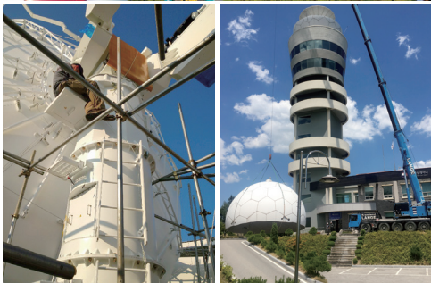
S-밴드 이중편파 기상레이더 설치공사 사진
